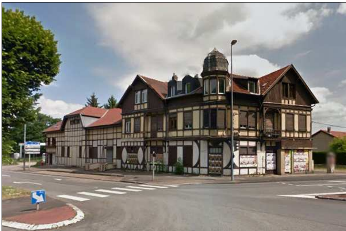
La maison à colombages située en bas de Saint-Julien-lès-Metz est en cours de démolition (Crédits photo : Google Street View)
