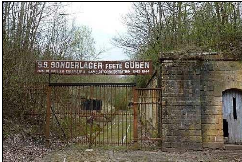
Le Fort de Queuleu est dans un état de délabrement avancé (Crédits photo : ufacbagnolet.overblog.com)
