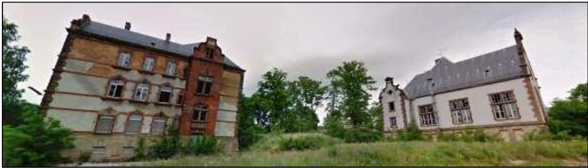
Bâtiments de la Caserne Ardant-du-Picq à Saint-Avoid (Crédits photo : Google Street View)
